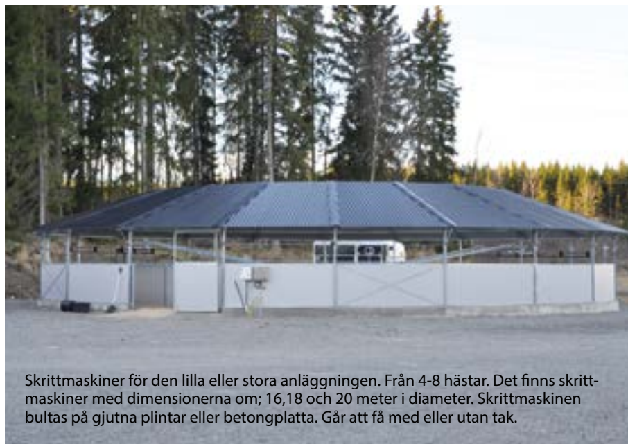
Skrittanläggningar drivs via en central drivenhet. Styrkan/farten är reglerbar.
